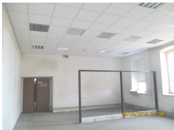
Nahozená zeď, konstrukce pro příčku, montáž konstrukce pro kazetový strop
