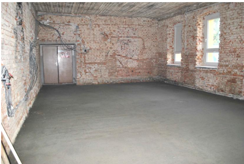
Nový beton na podlaze
