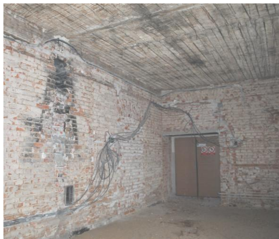
Stav po shoení zdiva a vykopání podlahy
