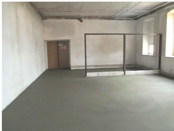
Nahozená zeď, konstrukce pro příčku, montáž konstrukce pro kazetový strop
