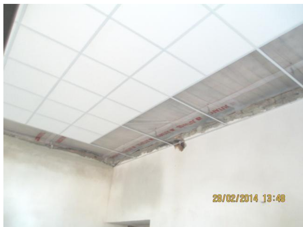
Nahozená zeď, konstrukce pro příčku, montáž konstrukce pro kazetový strop
